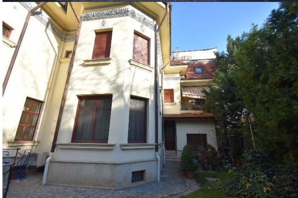
Vedere Subsol 2 C1:
