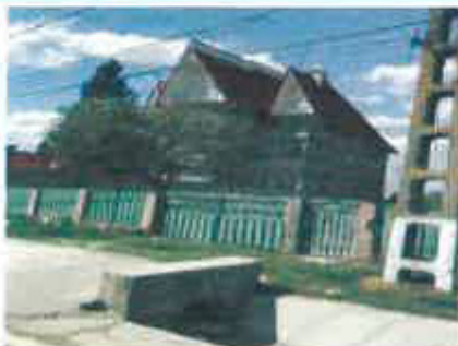
Vedere laterala proprietate
